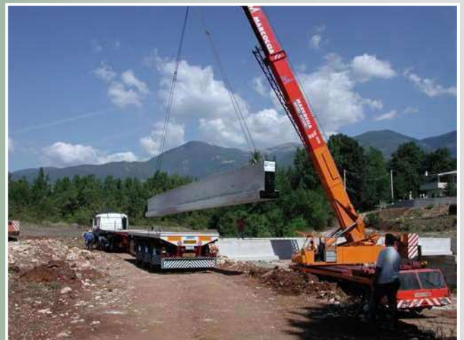
Montaggio travi porta solaio
