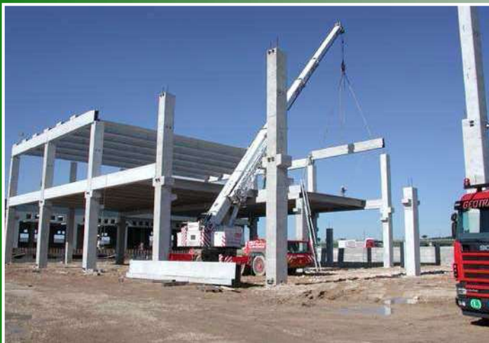
Montaggio travi porta solaio
