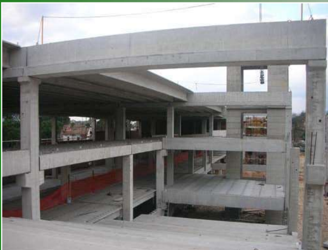
Strutture multipiano realizzate con Tegoli TT
