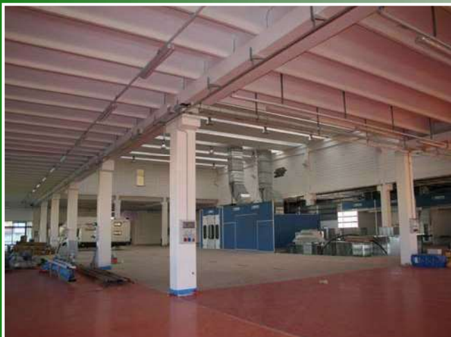
Struttura multipiano realizzata con Tegoli TT H50
