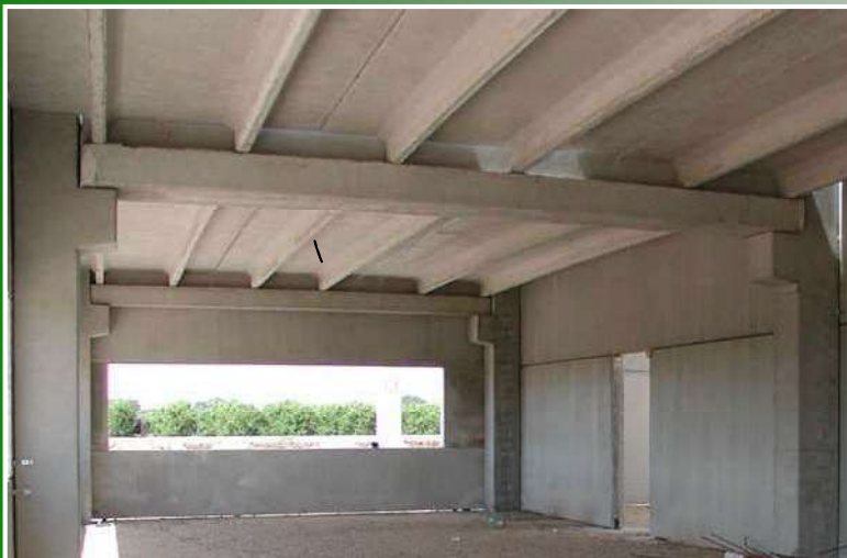
Struttura realizzata con Tegoli TT H30
