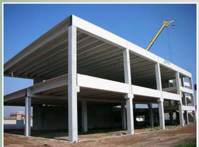
Strutture multipiano realizzate con Tegoli TT
