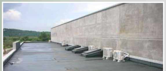
Impermeabilizzazioni su Tegoli TT
