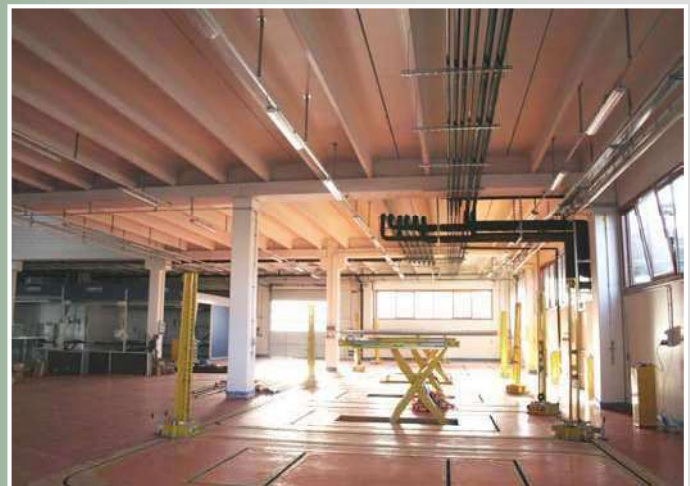
Struttura multipiano realizzata con Tegoli TT H50
